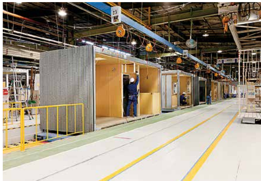
BINNEN EEN TIJDSBESTEK VAN SLECHTS ÉÉN DAG WORDT DEZE PREFAB-WONING VAN MISAWA HOMES IN ELKAAR GEZET.
